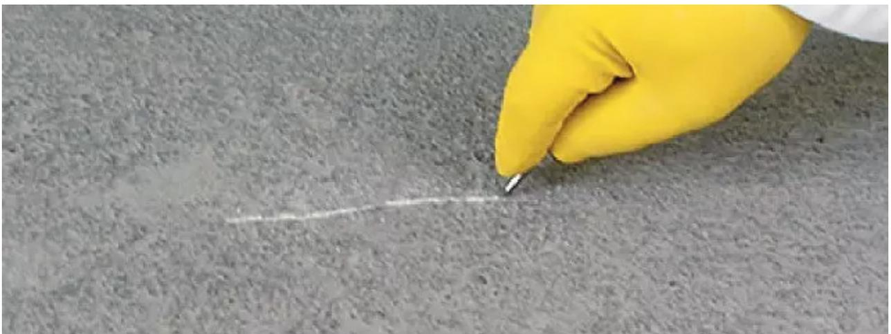
**NOTA:** O teor de umidade deve ser controlado previamente a instalação. Se o piso for instalado sobre contrapiso úmido, a água não conseguirá evaporar e, como consequência, podem ocorrer bolhas ou até mesmo o descolamento do produto. Os pisos vinílicos não devem ser entendidos como barreira contra umidade ascendente
