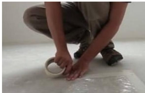
Após utilizar um dos métodos acima e constatar umidade no local, é preciso identificar a origem dessa umidade (ascendente – vem do solo, ou residual de outra origem). O contrapiso impermeabilizado corretamente, além de assegurar a preservação das estruturas, irá garantir que o piso vinílico tenha um excelente desempenho por muitos anos.
